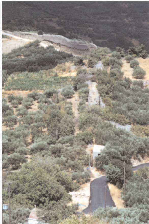
Fig. 8. The Lyttos siphon at Teixos.
